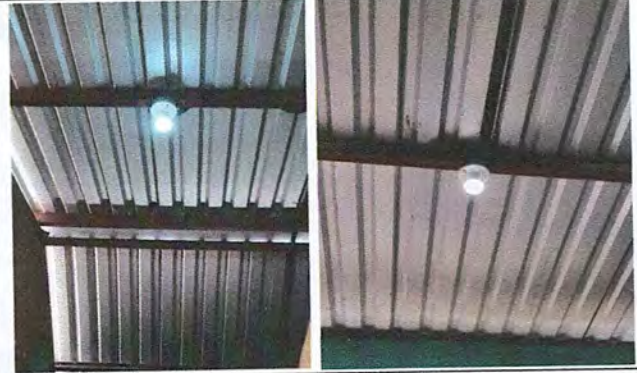
Foto 2: FINALIZACIÓN DEL TRABAJO DEL SISTEMA ELÉCTRICO
