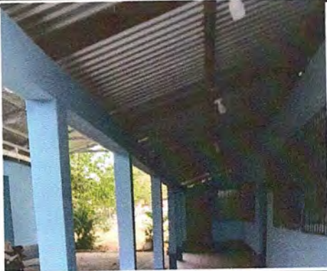
Foto1: FINALIZACIÓN DEL TRABAJO DEL SISTEMA ELÉCTRICO
