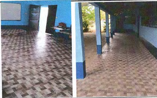
Foto 3: FINALIZACIÓN DE COLOCACIÓN DE PISO
