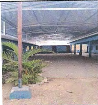
Foto 5: FINALIZACIÓN DE TECHADO DE PATIO
