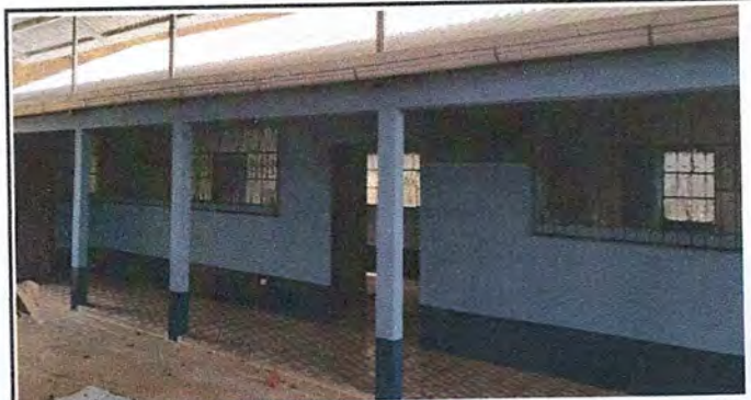
Foto 4: FINALIZACIÓN DE COLOCACIÓN DE PISO
